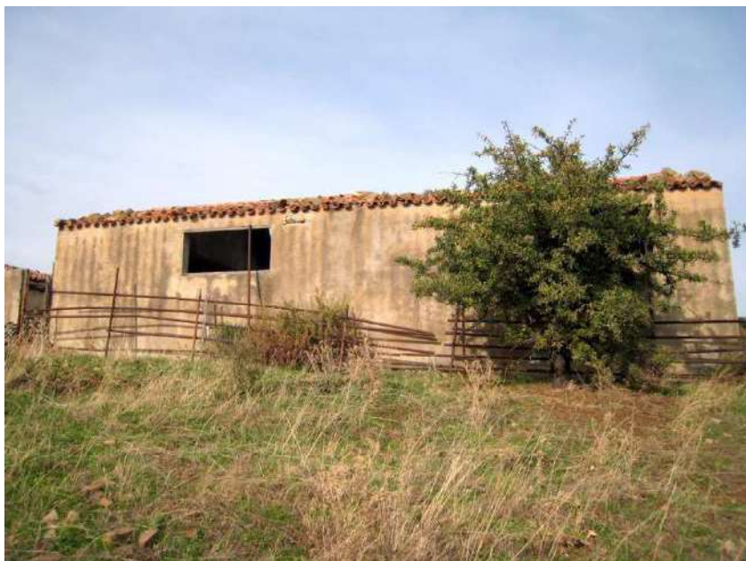
Foto n. 145. Altro prospetto dell'edificio.
