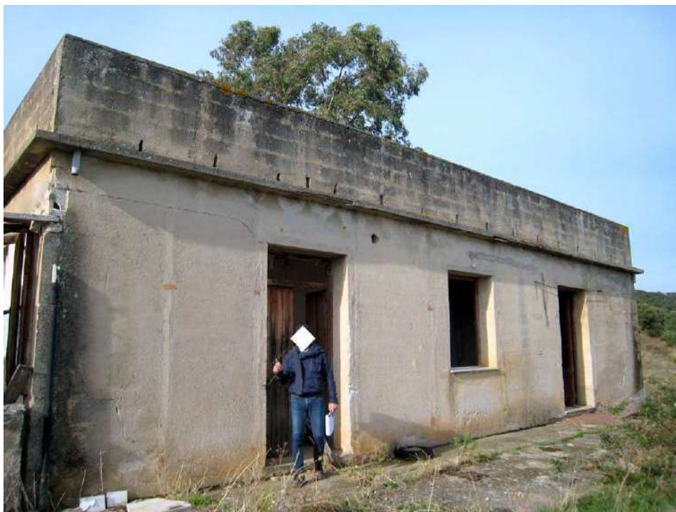
Foto n. 128. Il prospetto rivolto a valle con qualche lesione.
