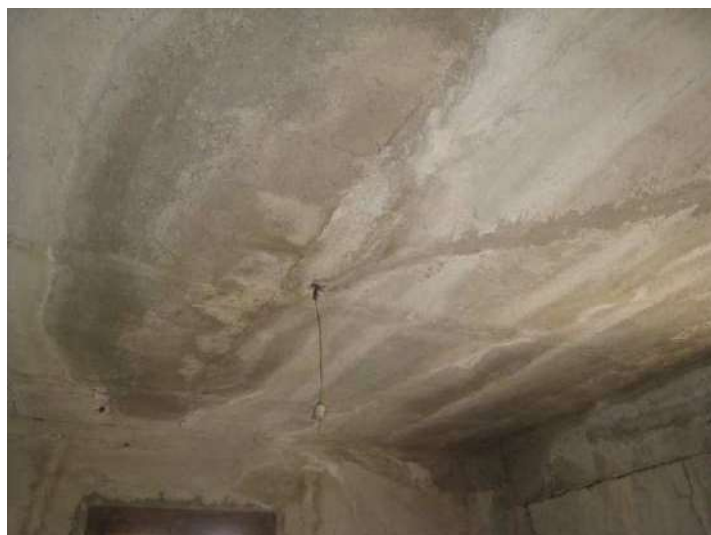
Foto n. 129. Il manufatto abusivo semi diroccato.
