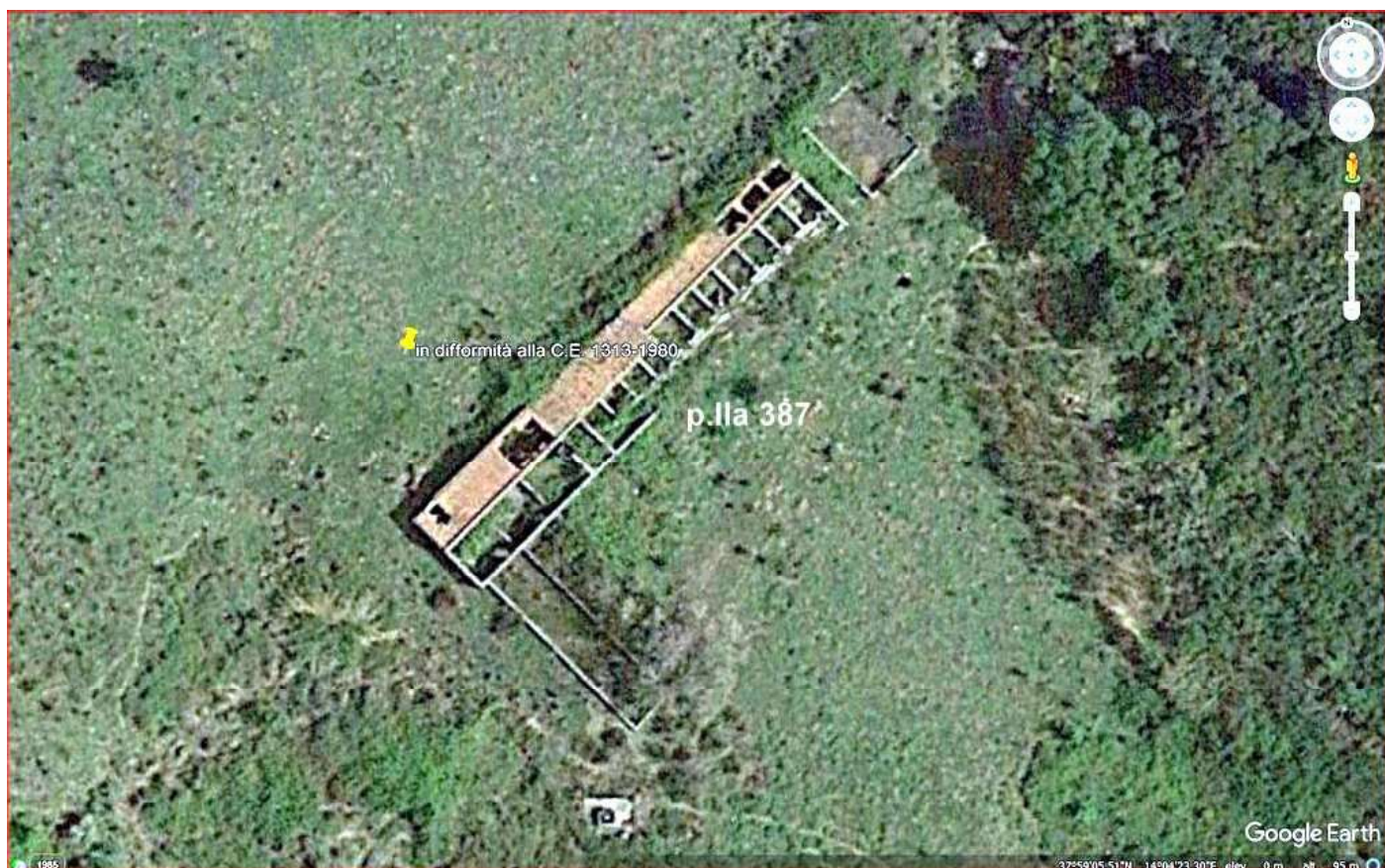
Foto n. 124. La porcilaia, p.Ila 387, con gli annessi è quasi interamente ceduta.
