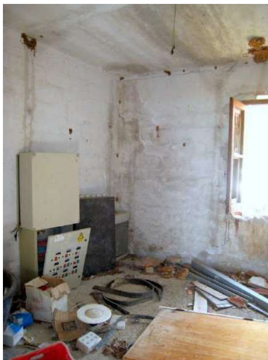
Foto n. 131-132. Le condizioni in cui si trovano gli ambienti interni. Lesioni piuttosto pronunciate sono presenti su alcune pareti.
